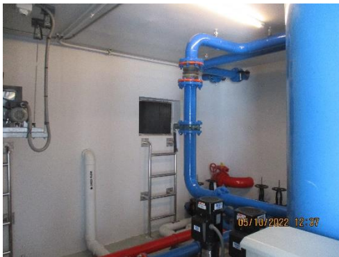
รูปที่ 2-27 ระบบจ่ายน้ำดับเพลิง
