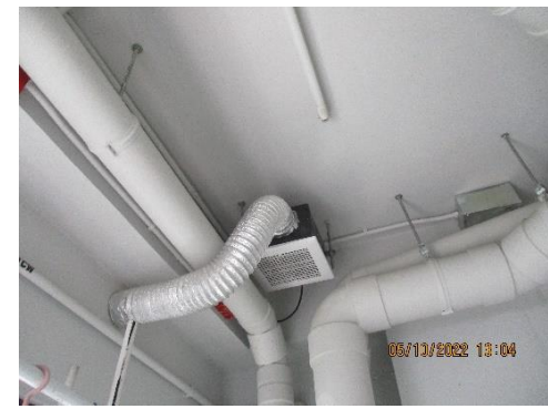
รูปที่ 2-24 ช่องดูดอากาศภายในห้องพักมูลฝอย
