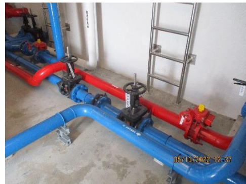
รูปที่ 2-27 ระบบจ่ายน้ำดับเพลิง
